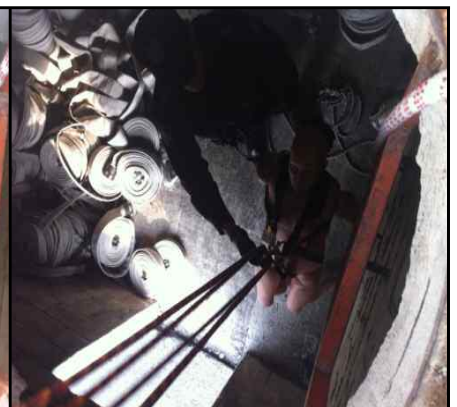
▶ 도르래와 요구조자용 안전벨트를 결착 후 “구조준비완료” 복창
