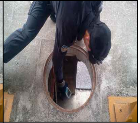
▶ 가스측정기를 이용하여 산소 및 유해가스 농도 측정
