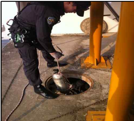
▶ 공기호흡기 실린더에 기구뭉기하여 맨홀내부 공기정화 실시
